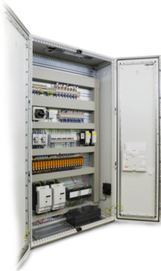
Steuerungsanlage für Rauch- & Wärmeabzug sowie automatisierte, natürliche Lüftung und geeignet für maschinelle Rauch- und Wärmeabzugsanlagen (MRA).
